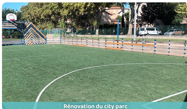
Rénovation du city parc
